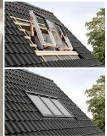
Mit seinen schlanken Profilen fügt sich das neue Studio-Fenster „3 in 1“ harmonisch in das geneigte Dach ein. Weil das Fenster aus einem großen Rahmenelement besteht, ist der Einbau für Handwerker denkbar einfach.
