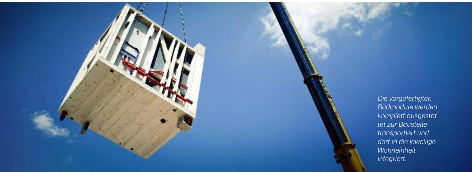
Die vorgefertigten Badmodule werden komplett ausgestattet zur Baustelle transportiert und dort in die jeweilige Wohneinheit integriert.
