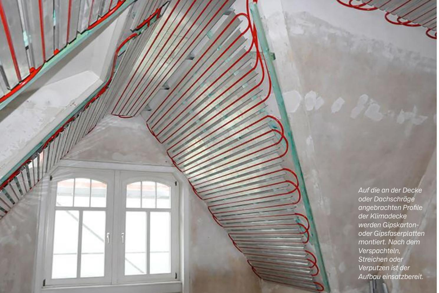
Auf die an der Decke oder Dachschräge angebrachten Profile der Klimadecke werden Gipskarton- oder Gipsfaserplatten montiert. Nach dem Verspachteln, Streichen oder Verputzen ist der Aufbau einsatzbereit.
